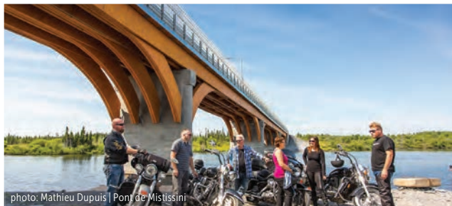
photo: Mathieu Dupuis | Pont de Mistissini
