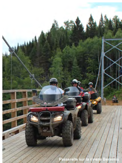
Passerelle sur la rivière Bersimis
